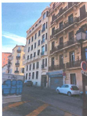
Les bâtiments situés en face avaient déjà des vues en vis à vis avant l'opération de déconstruction de la friche. la continuité de poursuivre le strajets routiers permet de créer un nouveau site intégré
