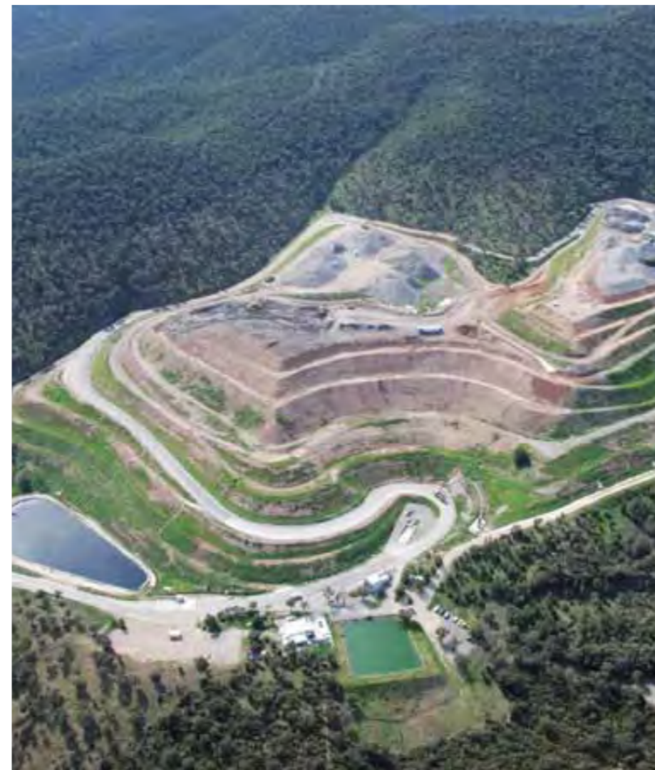
Centre de stockage de déchets non dangereux de Pierrefeu
