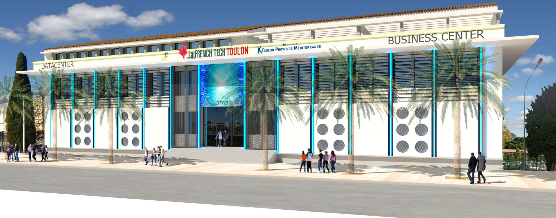
Vue du futur Hôtel d'Entreprises du numérique et DataCenter, avec son écran LCD en façade.
