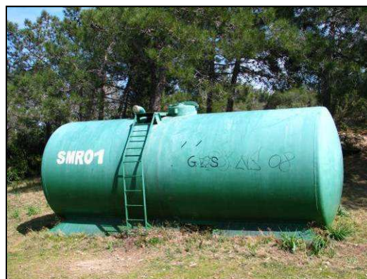
Figure 74 : Citerne destinée à la lutte contre l'incendie
