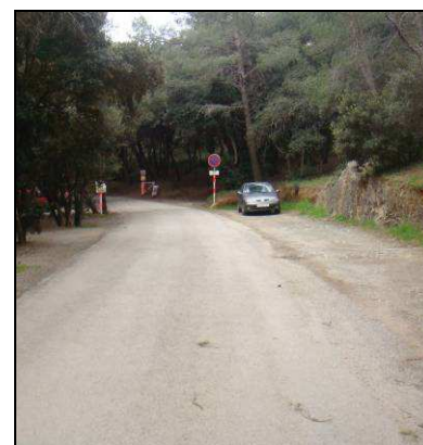
Figure 72 : Route de la corniche varoise (Six-Fours-les-Plages)
