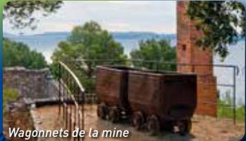
Wagonnets de la mine
