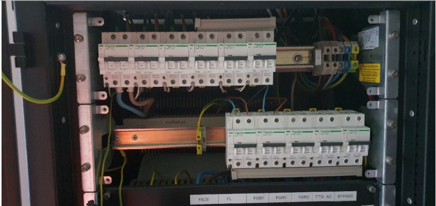
Vue disjoncteur câble apparent
