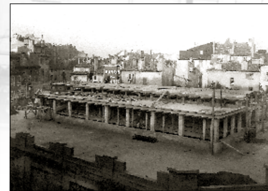
Chantier des Halles de Toulon - 1928
