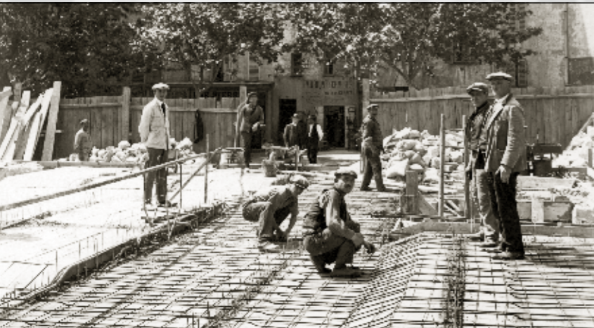
Construction d'une dalle en béton armé
