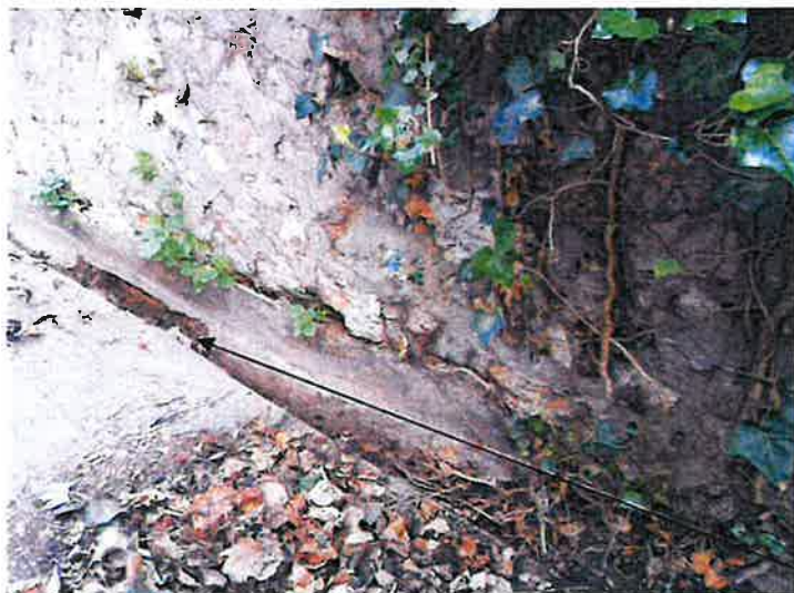
La cunette de récupération des eaux de ruissèlement est en mauvais état l'eau s'infiltre sous la dalle et la soulève
