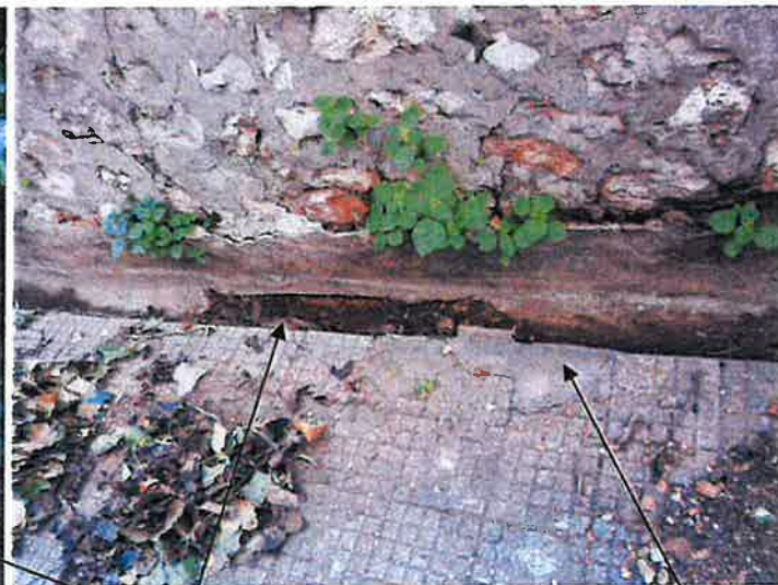
La cunette de récupération des eaux de ruissèlement est en mauvais état l'eau s'infiltre sous la dalle et la soulève
