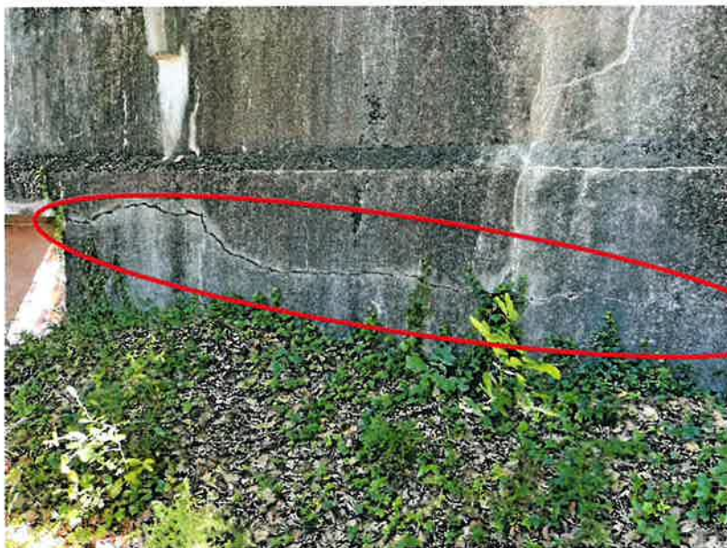
Vue d'ensemble de la fissure horizontale
