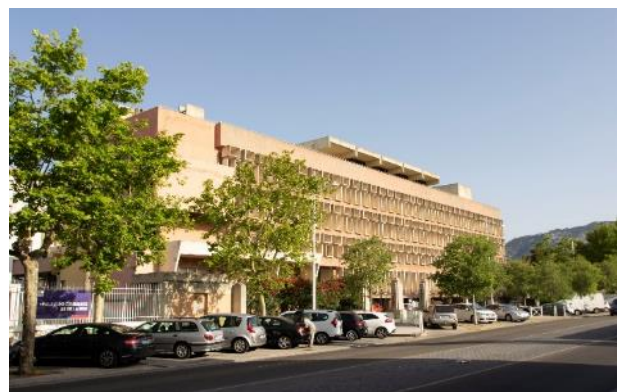
Site n°3 : bâtiment de la DDTM
