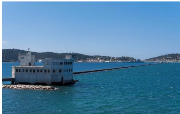
Site n°2 : Pipady, ancien môle des Torpilles
