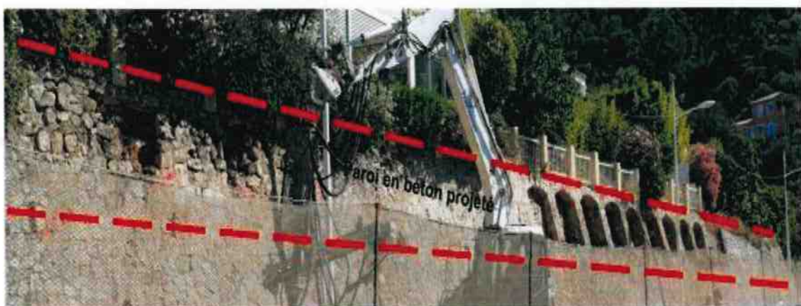
Vue en face du projet-zone à conforter par une paroi en béton projeté
