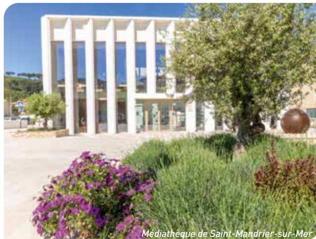
Médiathèque de Saint-Mandrier-sur-Mer
