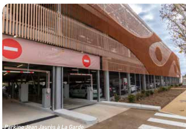
Parking Jean Jaurès à La Garde
