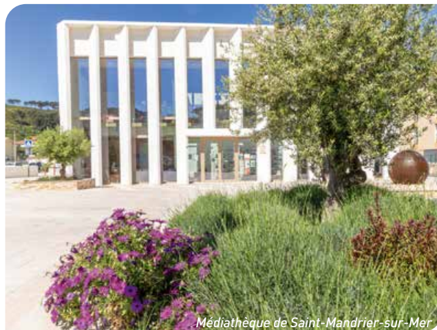
Médiathèque de Saint-Mandrier-sur-Mer
