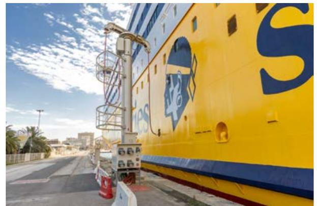
Ce dispositif est adapté à tous les navires de type ferry et croisière, en 50 et 60 hertz, peut fournir de l'énergie en 6600 et 11 000 volts et distribuer de 1 à 12 mégawatts. Il produit et stocke une partie de l'énergie nécessaire grâce à une centrale photovoltaïque faisant aussi office d'ombrière.
