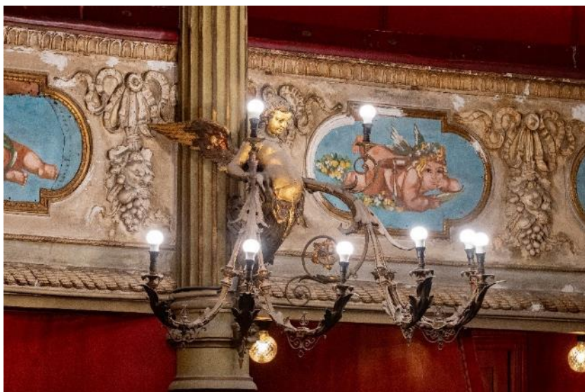
Photo avant travaux, détails du balcon de la salle et essai de dégagement de la toile marouflée putti
