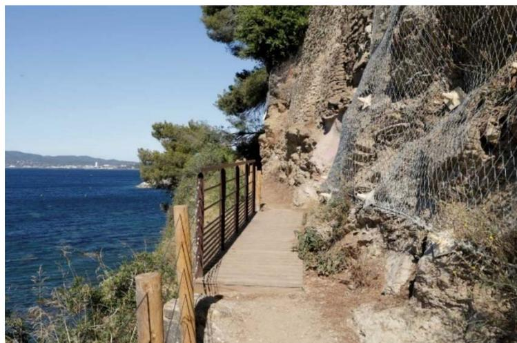
**Le talus en amont du sentier**, correspondant à la cicatrice du glissement, a été traité par la réalisation d'**ouvrages de confortement type paroi clouée et microberlinoise ancrée**. Les travaux au droit de cette section correspondent à la **création d'une passerelle** (structure métallique) de franchissement, en intégrant la sécurisation des appuis de fondation de l'ouvrage et la pose d'un double garde-corps métallique.
